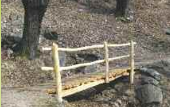
Ponte in legno
